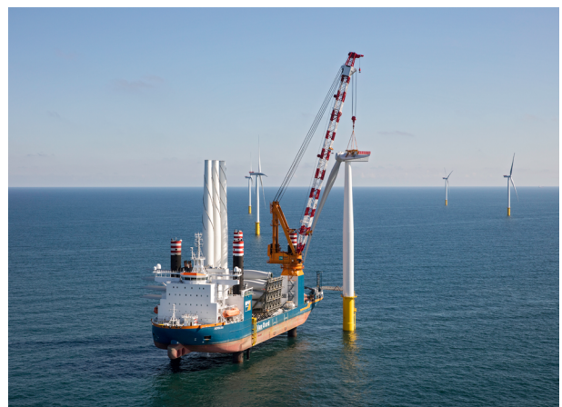
Een windturbine wordt op zee in elkaar gezet
